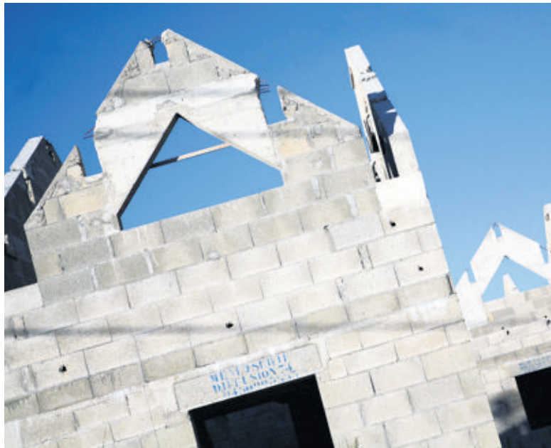
Seuls ceux dont les intérêts sont lésés de façon directe et spéciale par une construction possèdent l'intérêt requis par la loi pour recourir contre le chantier. LUCIEN FORTUNATI
